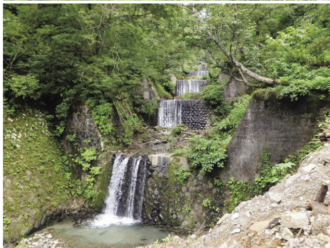
(上) 白岩砂防堰堤（えんてい）。昭和14年に完成 (下) 泥谷砂防堰堤（えんてい）。昭和8年に完成
