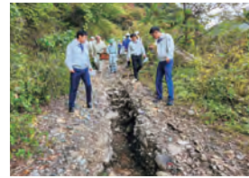
▲豪雨のため激しく洗掘された林道
